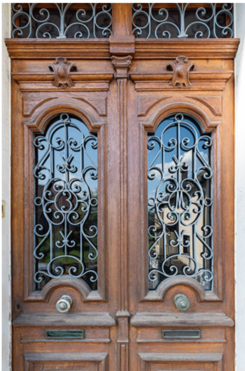
Logement : détail de la porte d'entrée.
