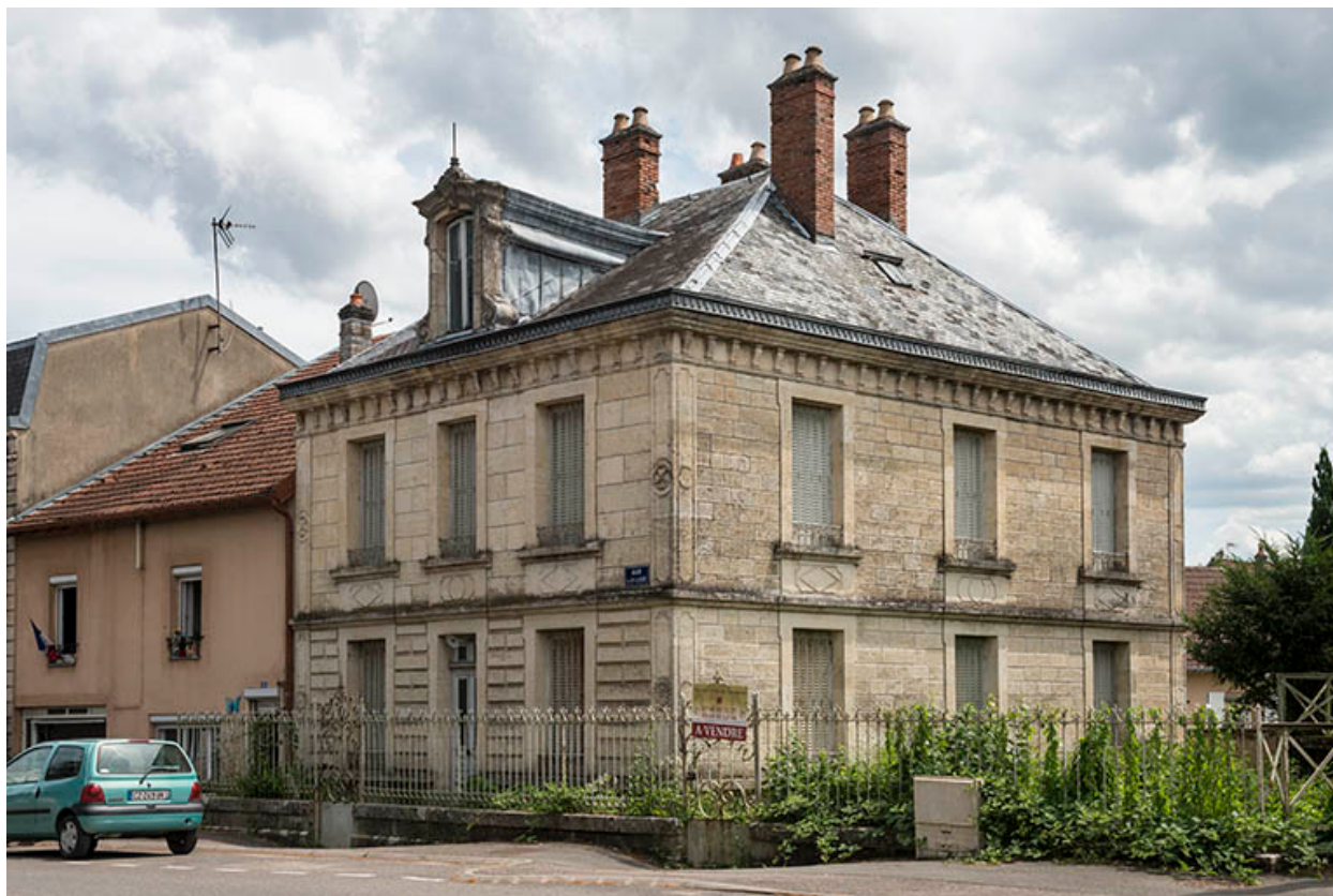
Élévation sur la rue du Pont-de-la-Balance, vue de trois quarts.
