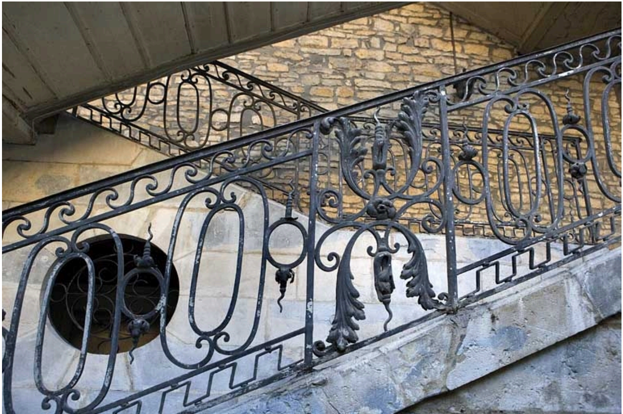
Détail de la rampe en fer forgé de l'escalier à cage ouverte.
