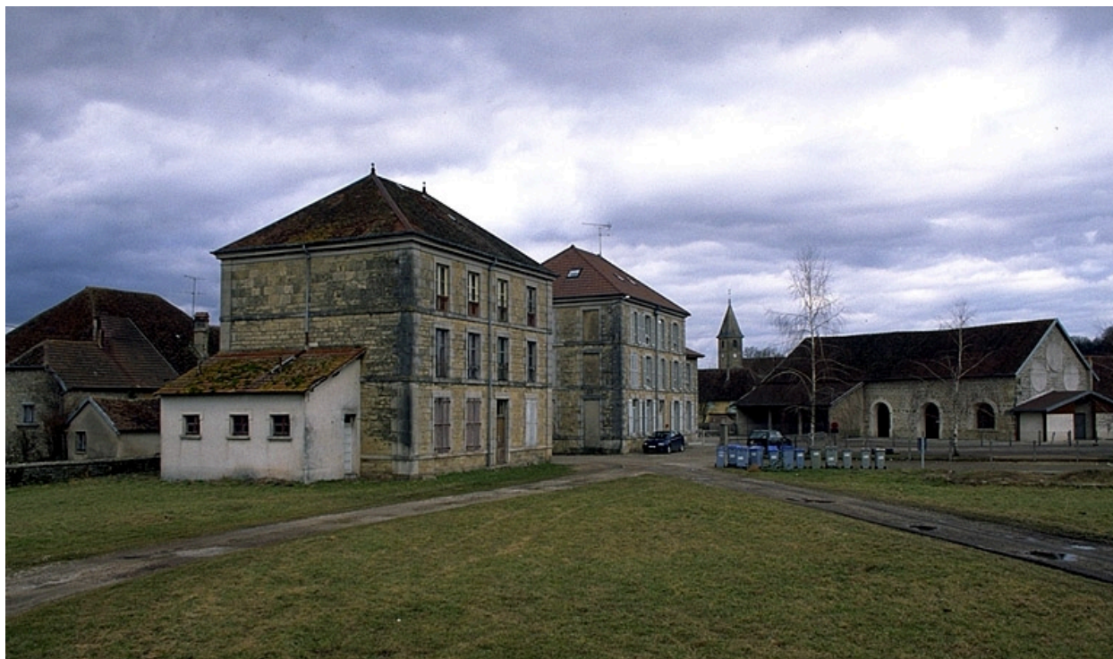
Saline de Grozon : bâtiments des bureaux et logements à gauche, de la machine d'extraction à droite.
