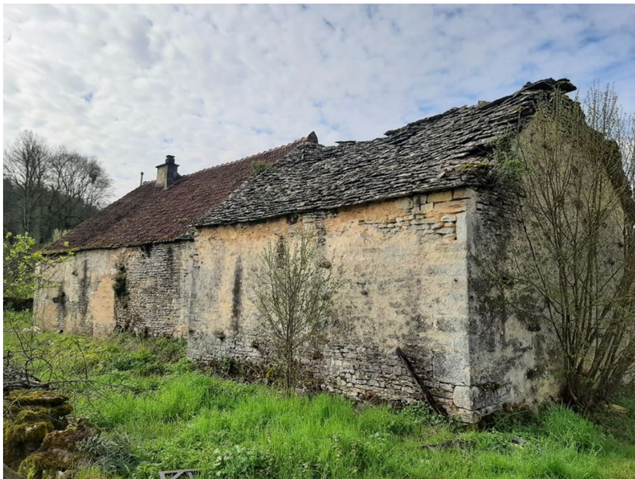
Vue de l'élévation nord de la grange.
