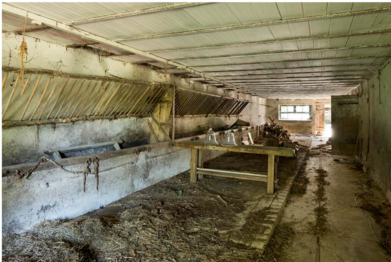
Vue intérieure de l'écurie.
