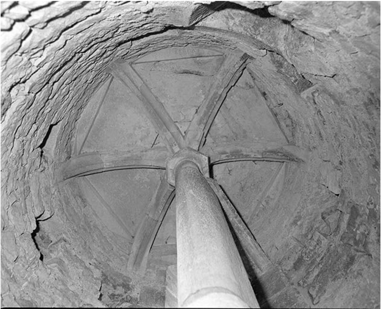
Tourelle de l'escalier du clocher : voûte.
