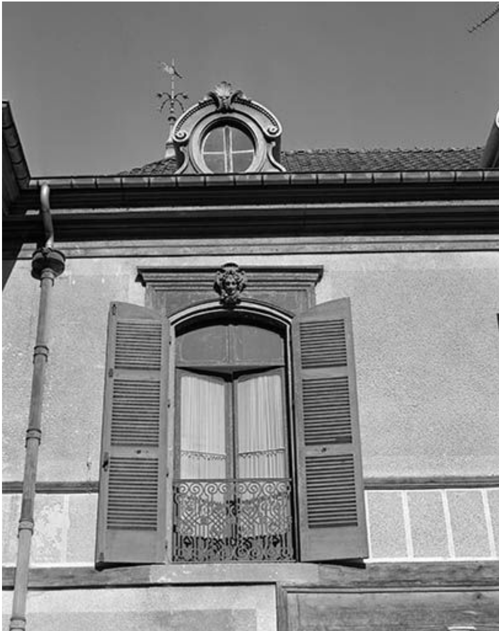
Façade postérieure : une baie du 1er étage.
