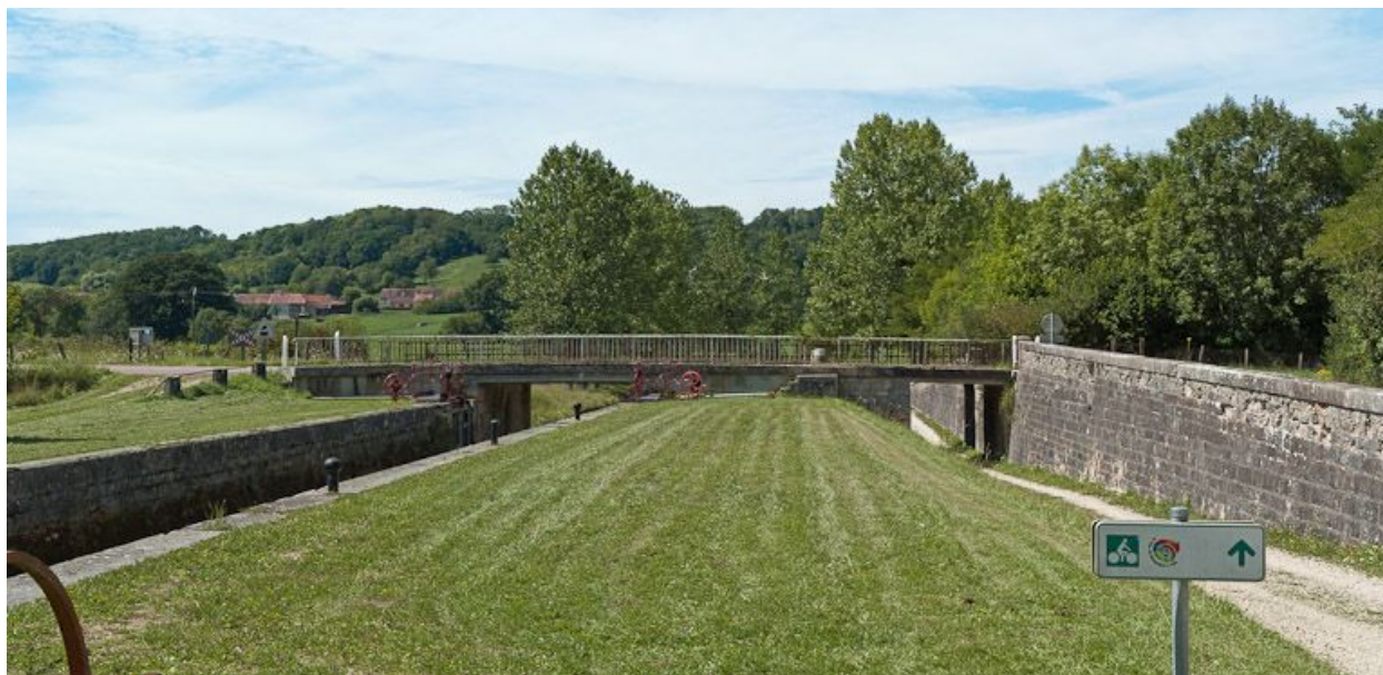
Vue du pont routier depuis l'amont.
