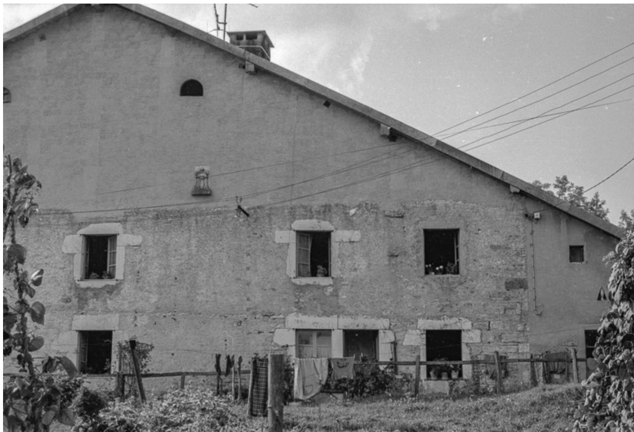
Façade antérieure : partie droite.
