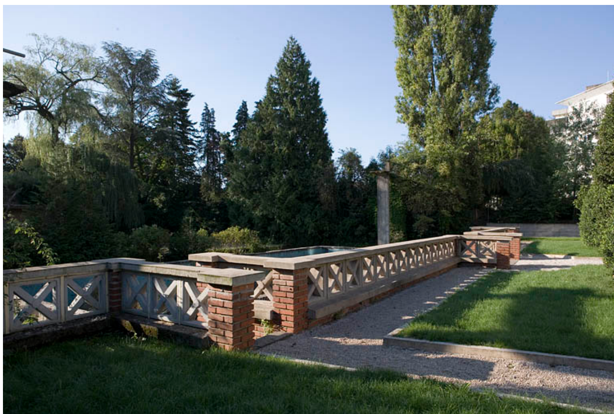
Jardin : garde-corps, du côté de l'usine.
