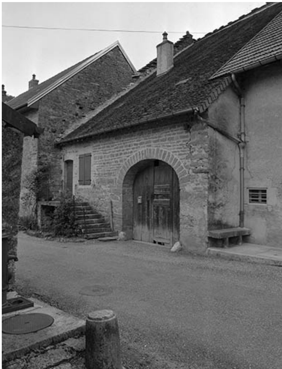
Ferme située rue du Moulin : façade antérieure.
