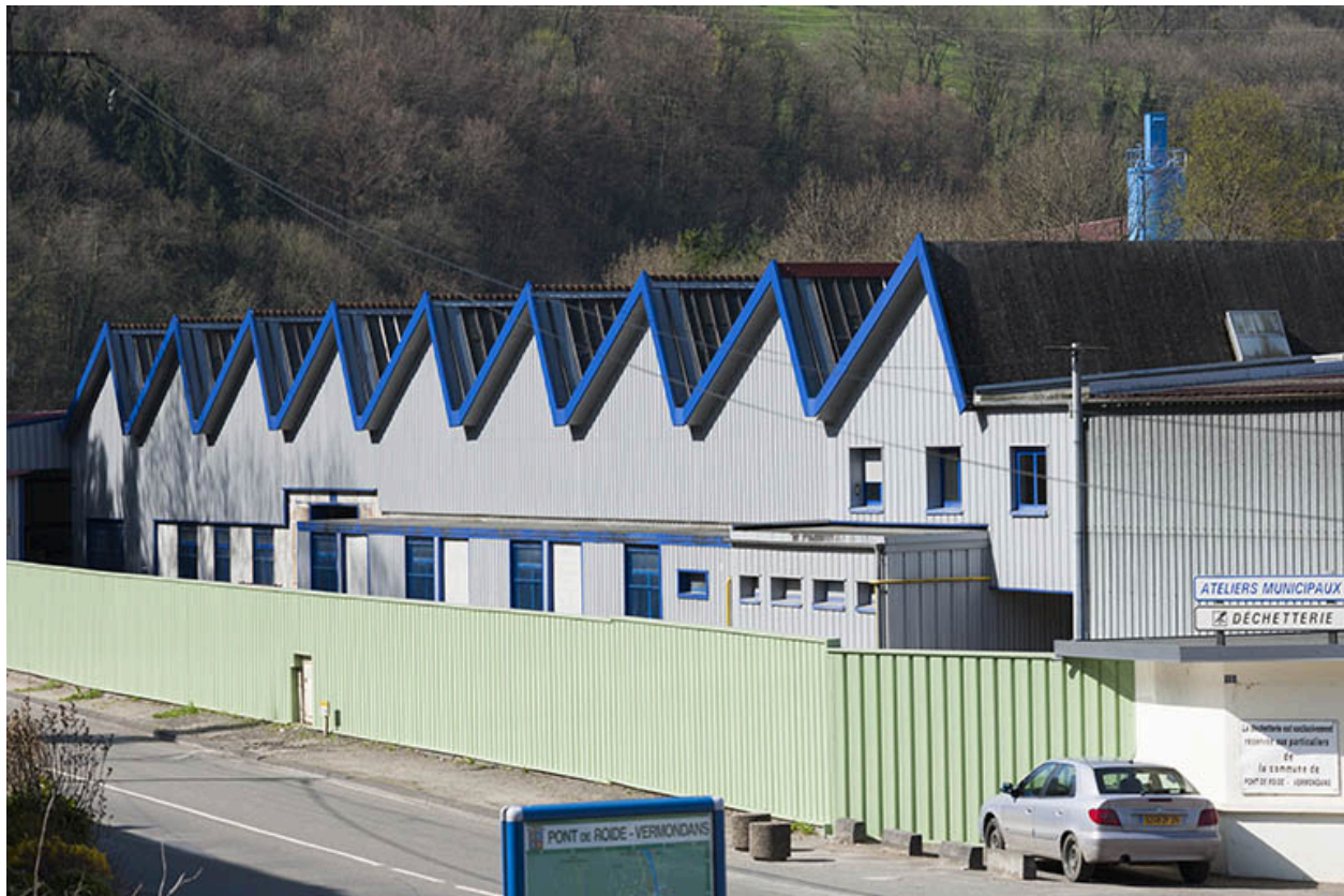
Ateliers sud de la rive droite.
