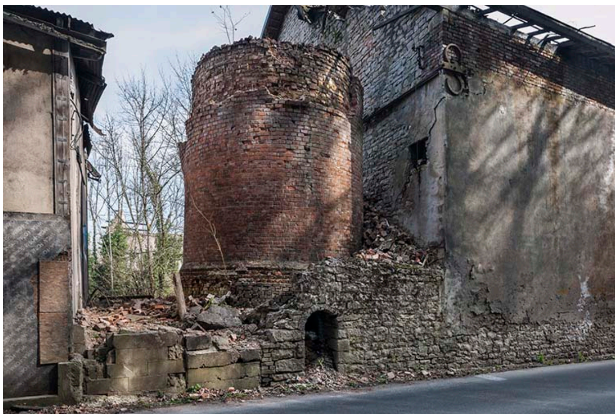
Base de la cheminée et la chaufferie.
