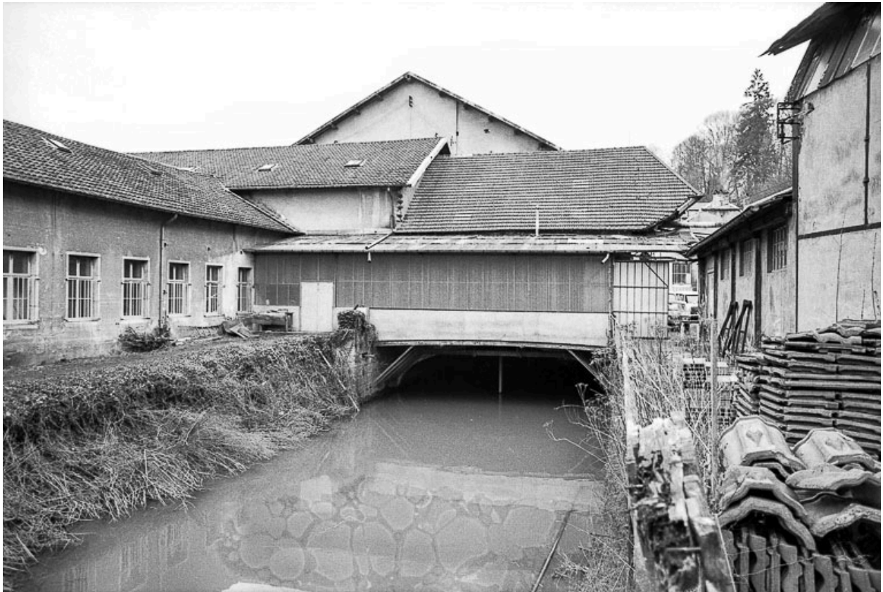
Canal de fuite principal en 1979.
