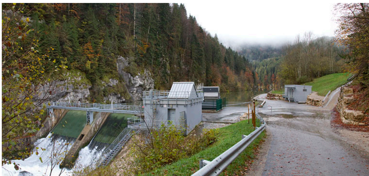
Barrage du Refrain : vue d'ensemble depuis l'aval.
