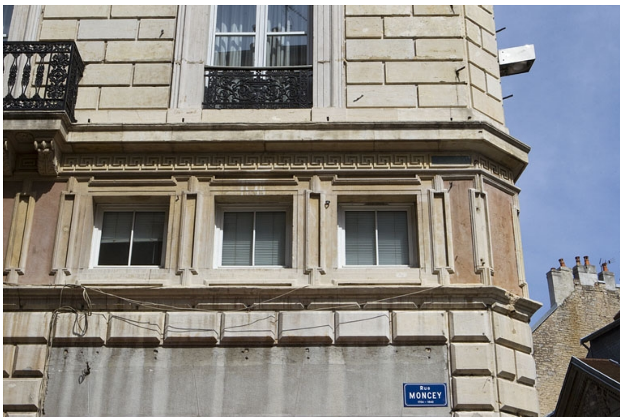
Façade antérieure, partie droite : détail de l'entresol.
