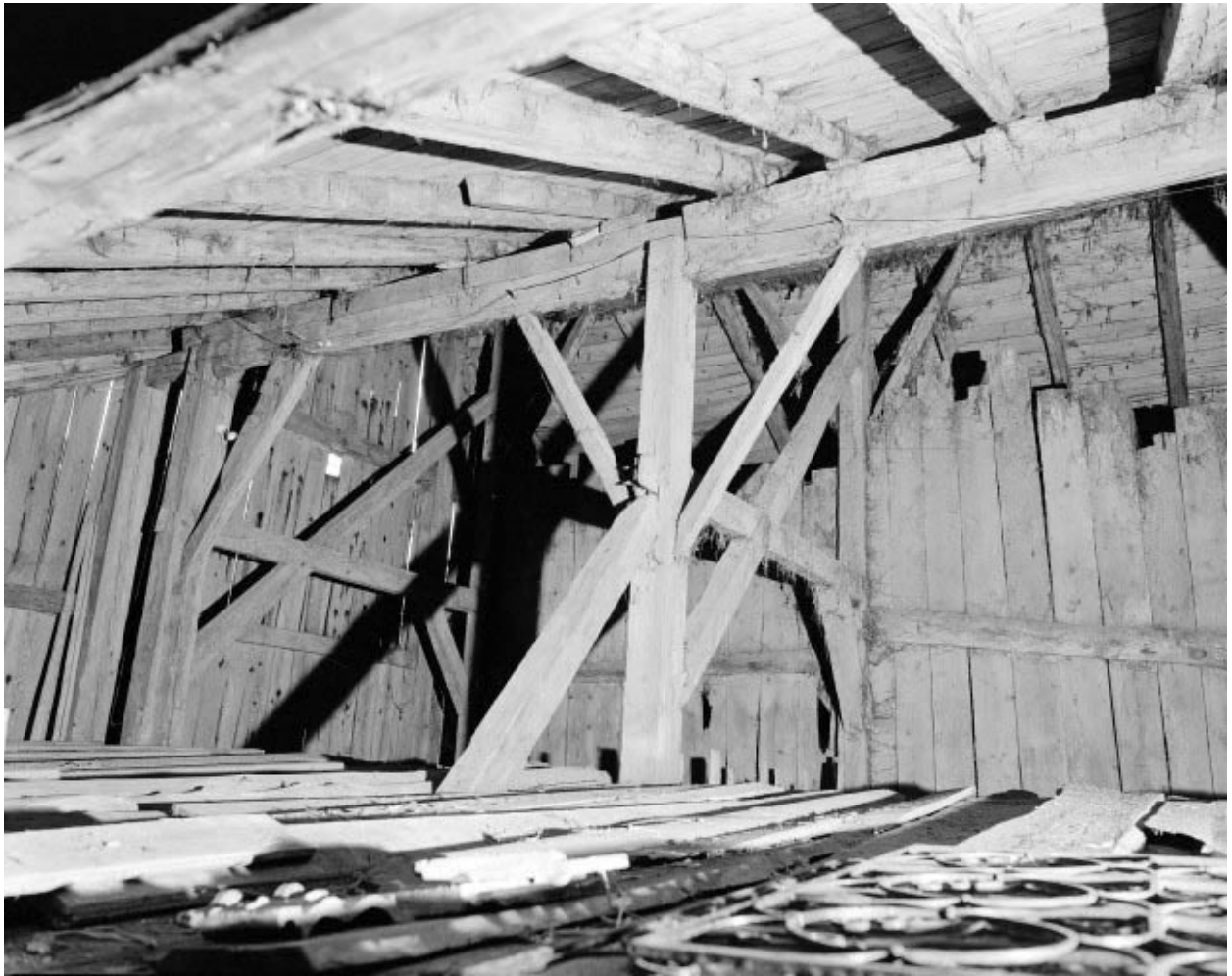
Intérieur en 1977, combles : fermes de charpente postérieures.
