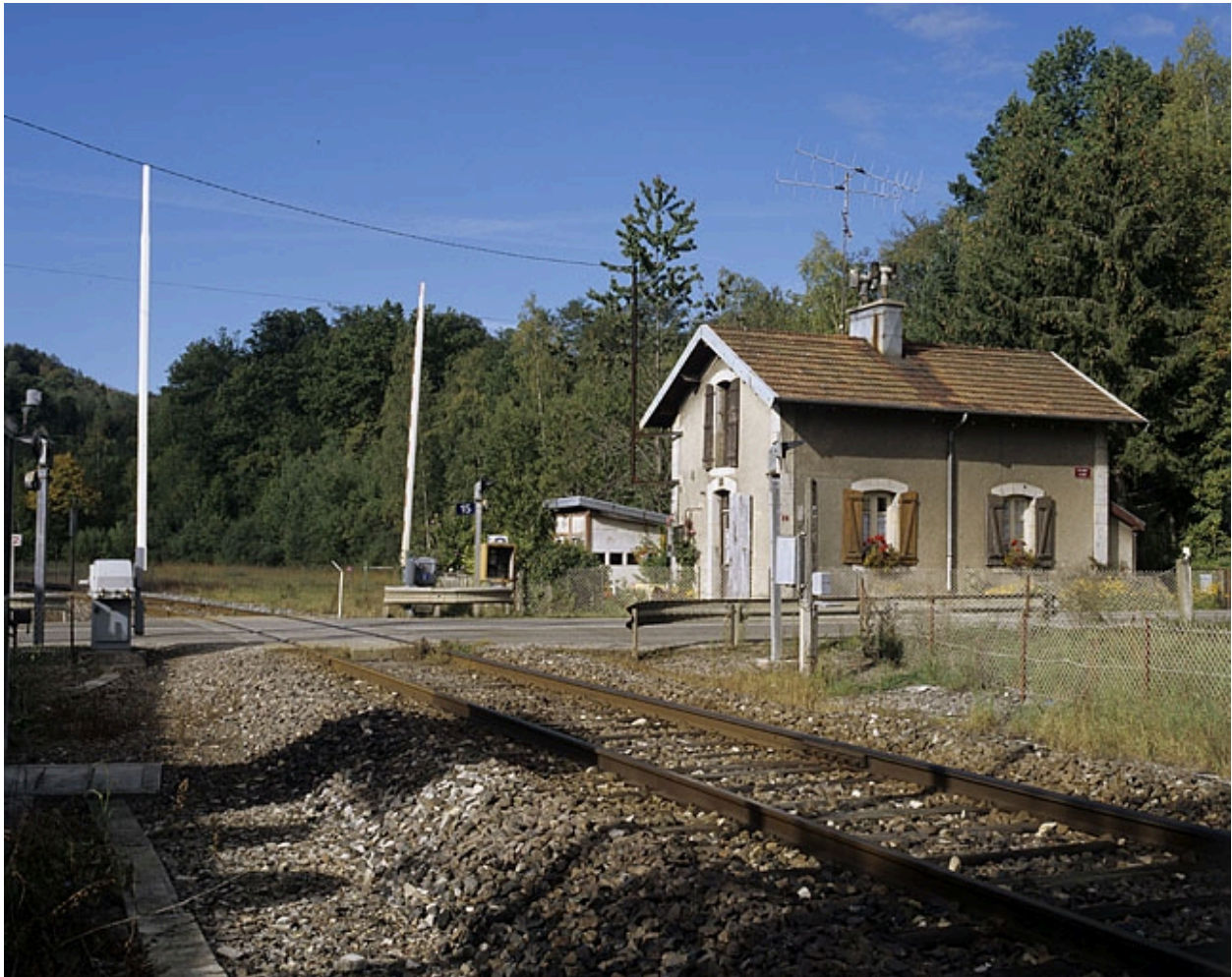
Façades antérieure et latérale droite.
