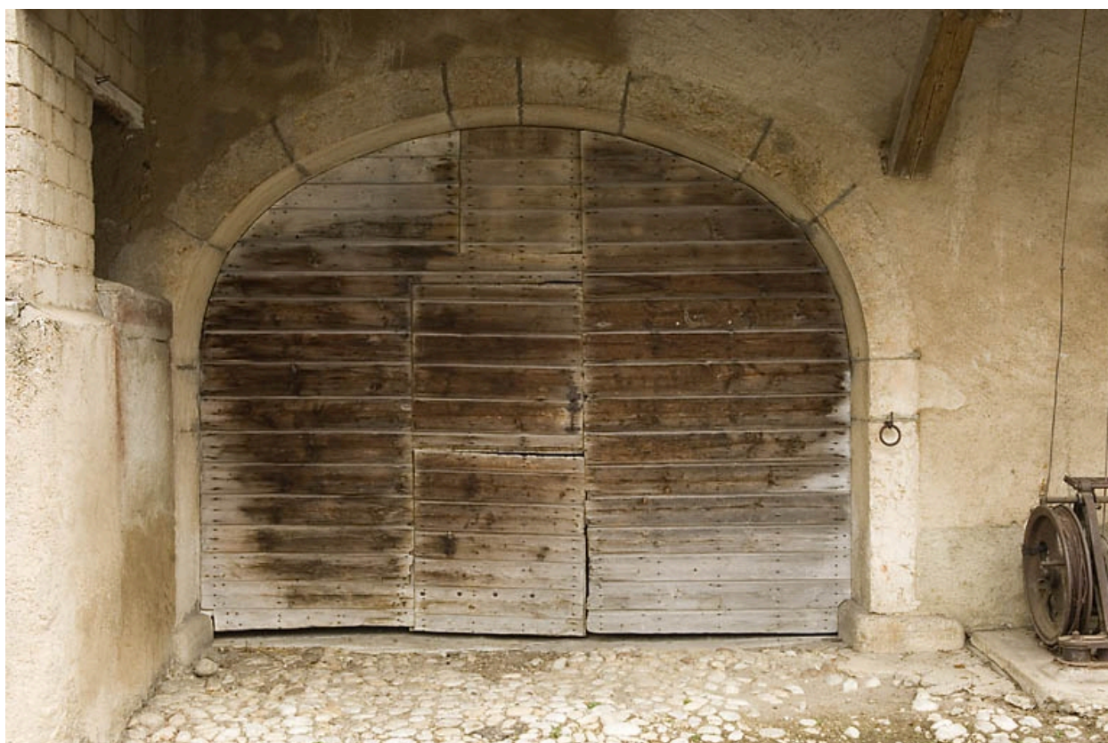
Façade antérieure : porte de la grange.
