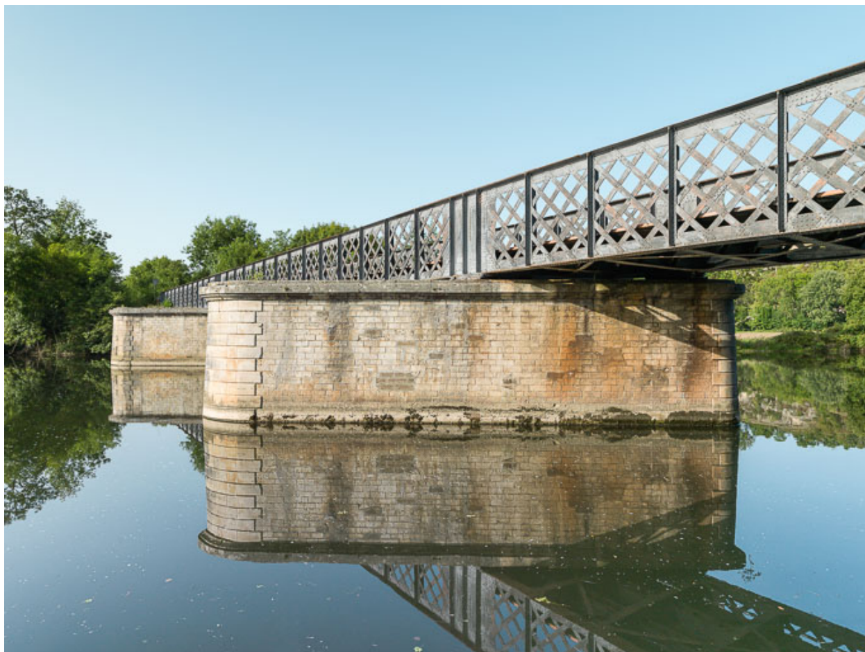
Vue du pont.
