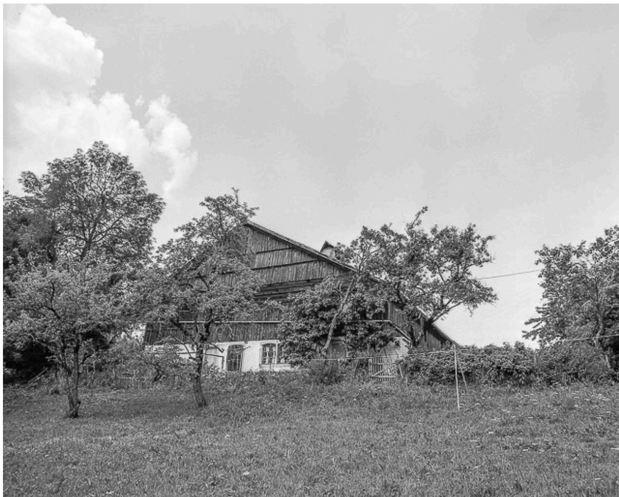
Ferme située au lieu-dit Le Prélot : façade antérieure.
