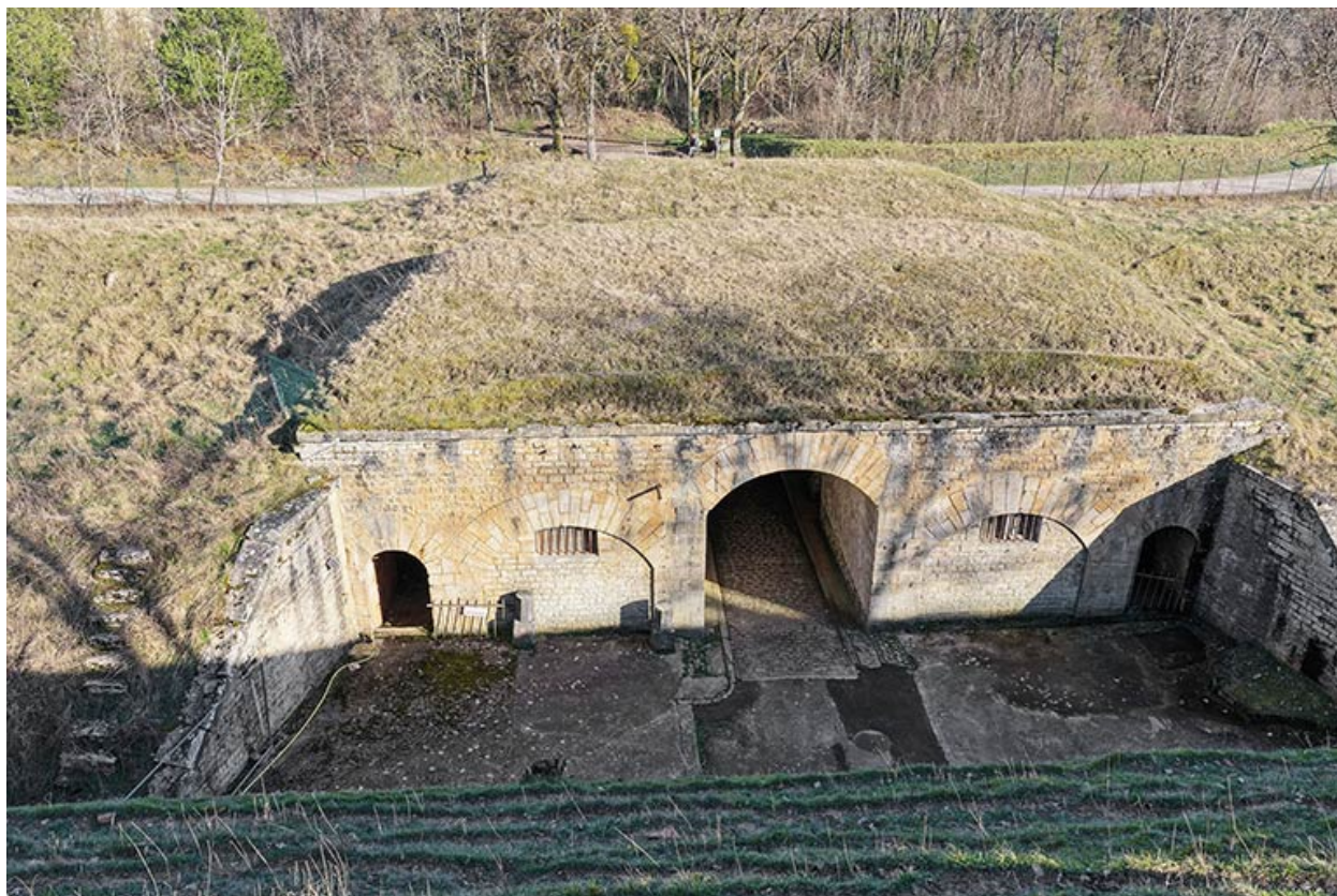
La gorge du bâtiment d'entrée. (vue aérienne).
