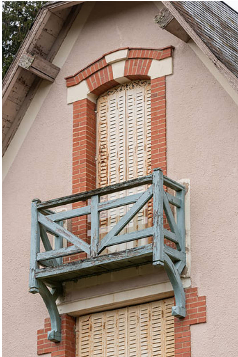
Mur-pignon en façade, garde-corps en bois du balcon.
