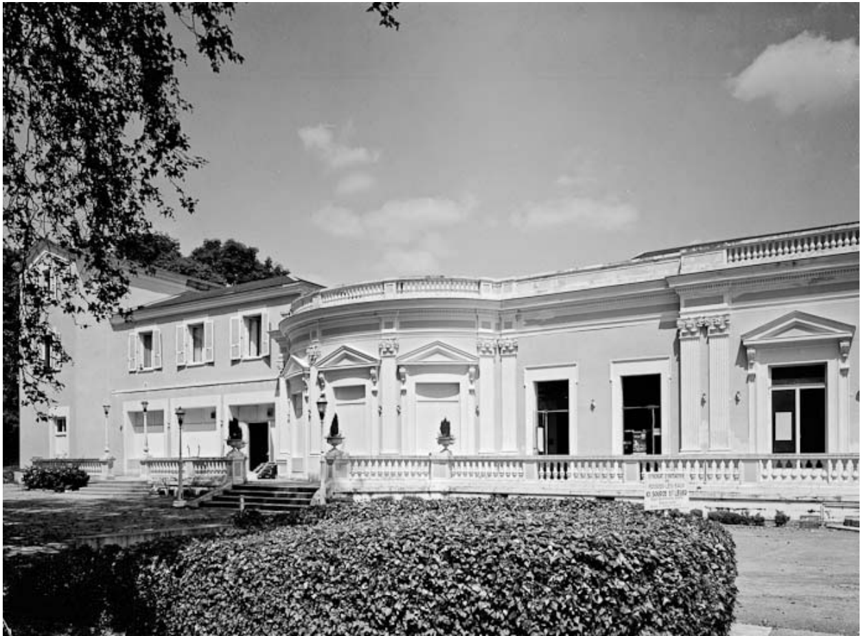
Façade, vue depuis le sud-ouest.
