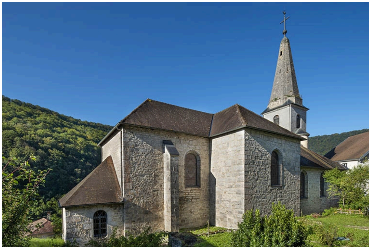
Façade latérale gauche en 2021.
