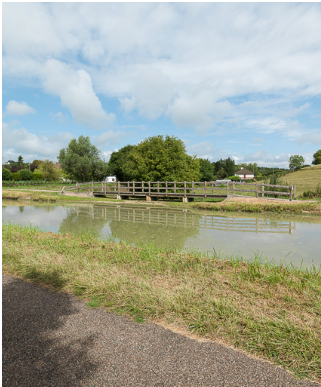
Vue d'ensemble de l'aqueduc.
