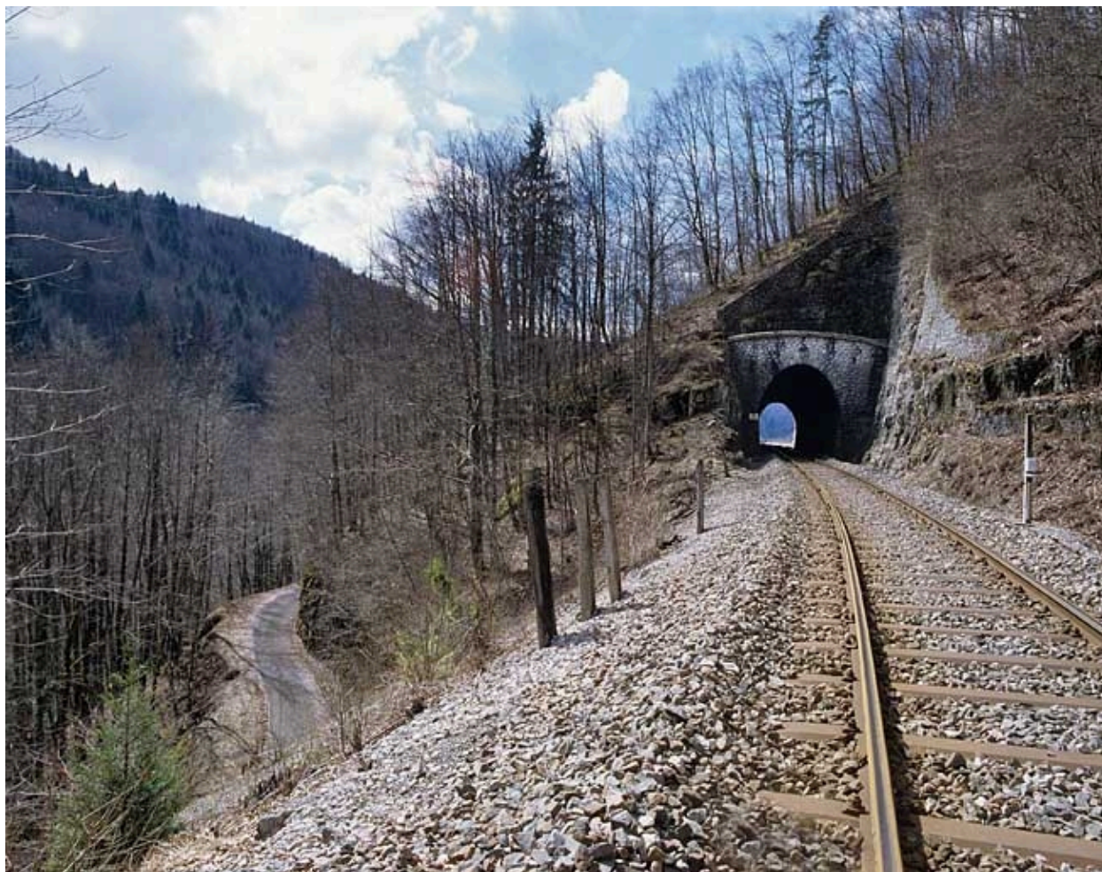
Tunnel de Tancua : vue d'ensemble, côté Andelot-en-Montagne (nord).
