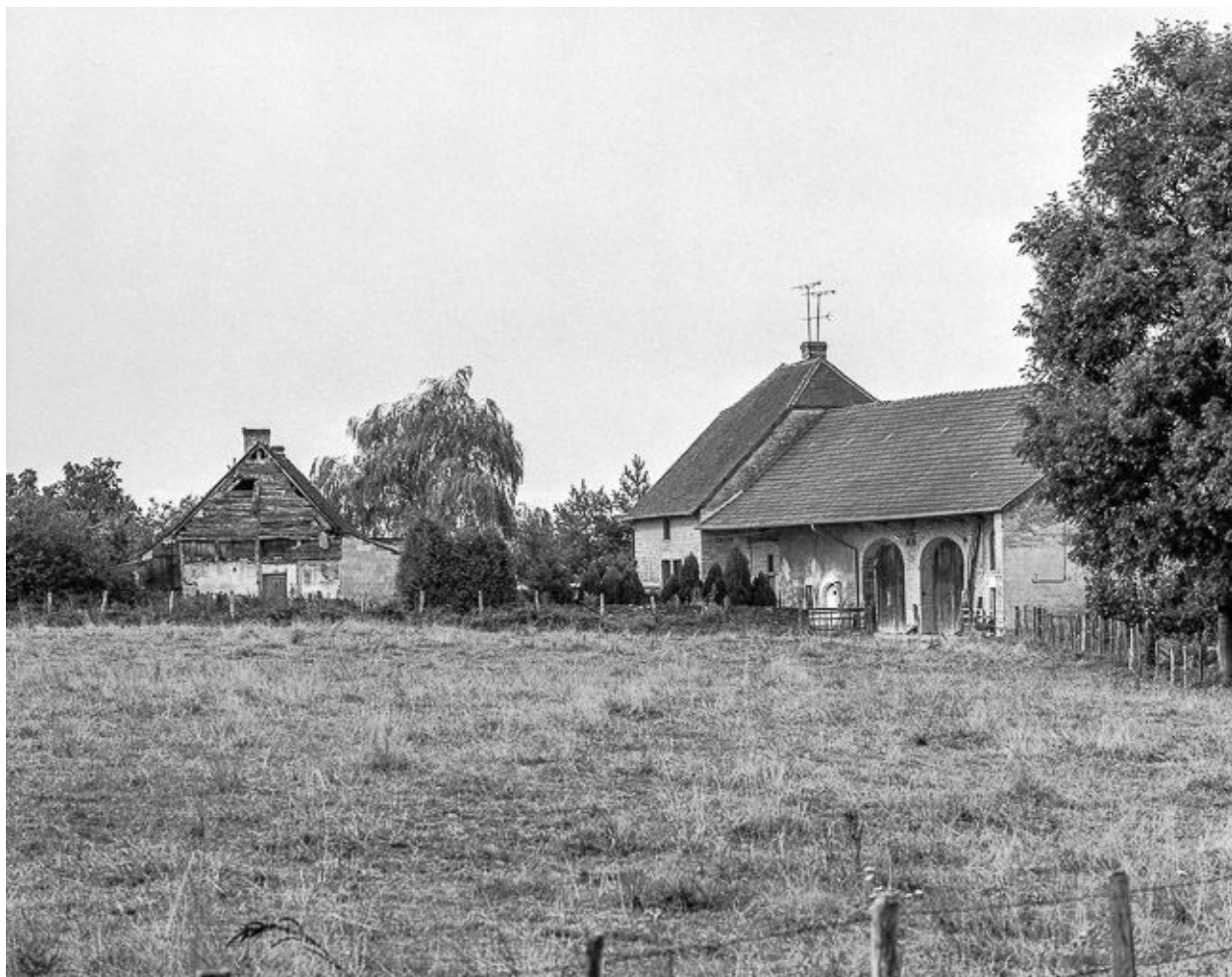
Ferme située chemin des Golards.
