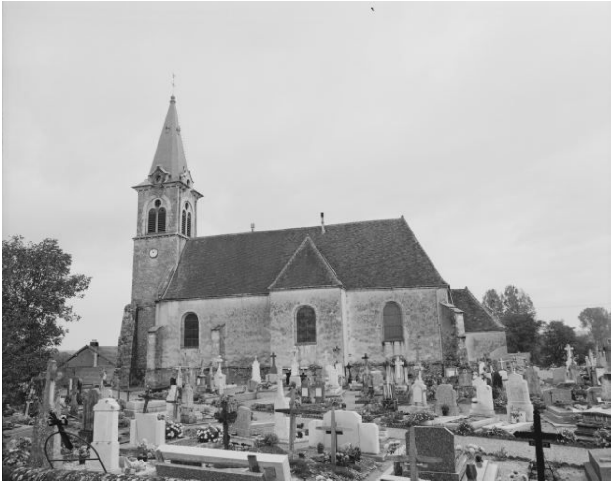
Façade latérale droite.
