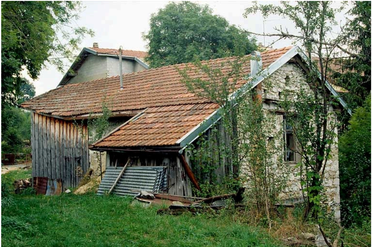
Façades postérieure et latérale droite.
