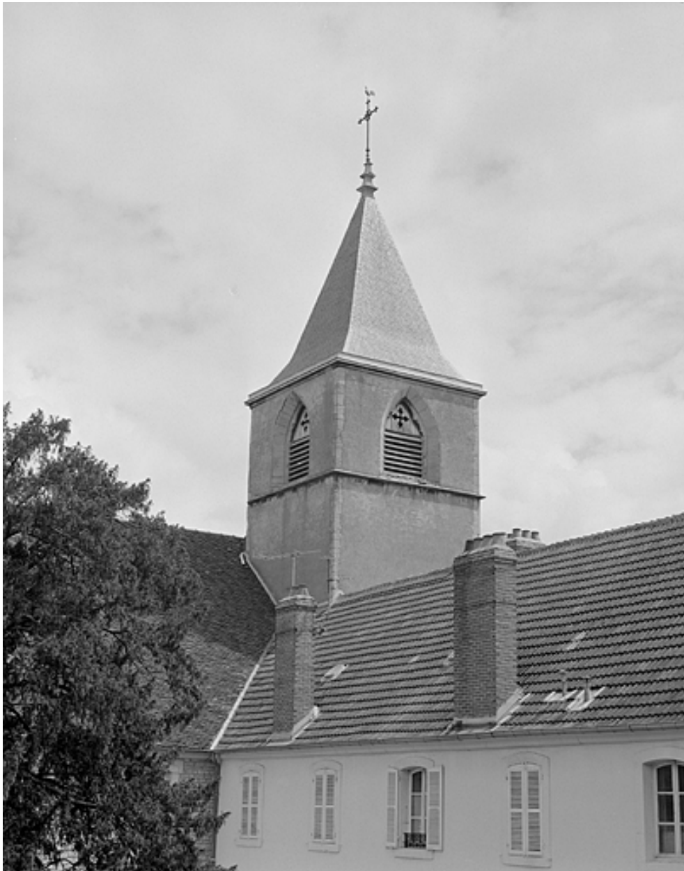
Eglise, vue générale du clocher depuis le sud-ouest.
