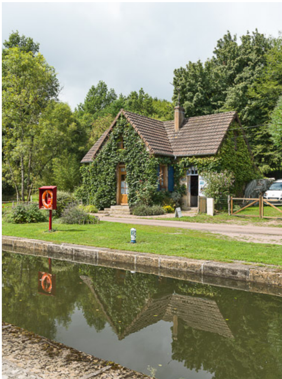
Vue de la maison éclusière.
