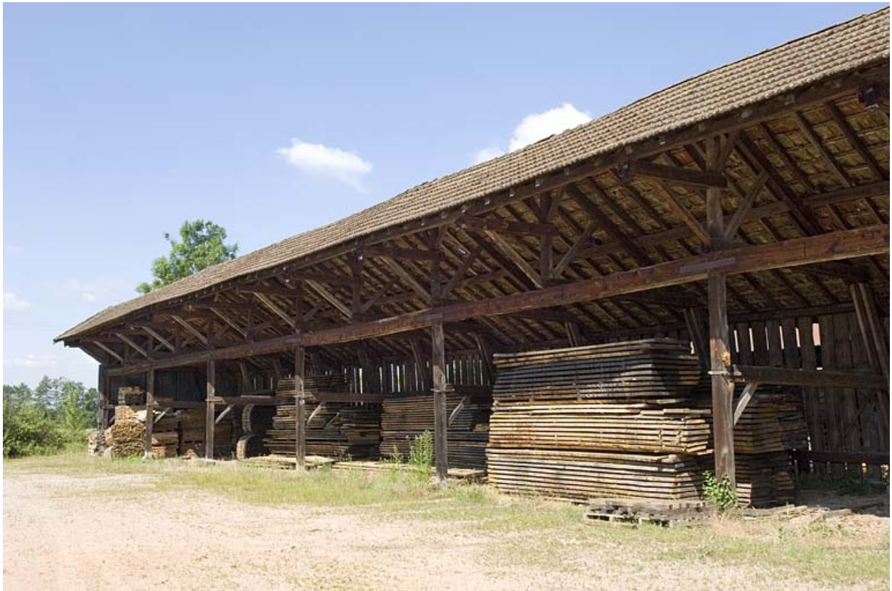
Entrepôt industriel ouest. Vue de trois quarts.
