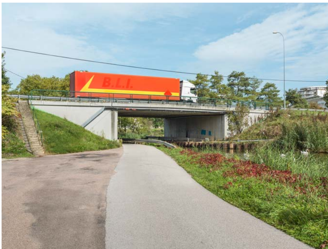
Vue d'ensemble du pont.
