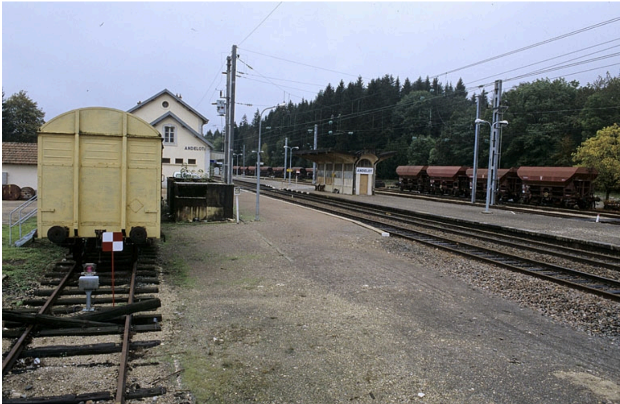
Vue d'ensemble rapprochée, depuis le nord-est (côté Vallorbe).
