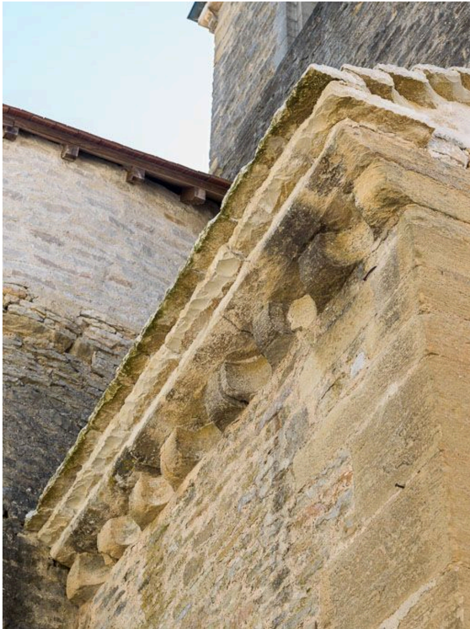
Elévation nord-est, détail des corniches.
