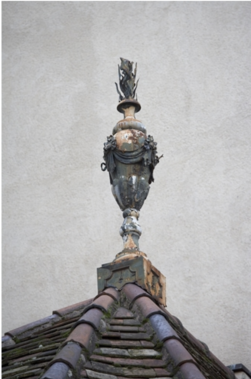
Détail d'un épi de faîtage sur l' une des toiture des communs.
