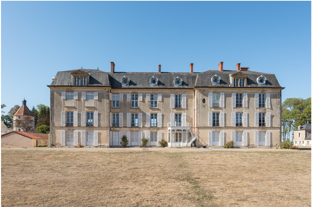
Façade sur le parc, vue de face.
