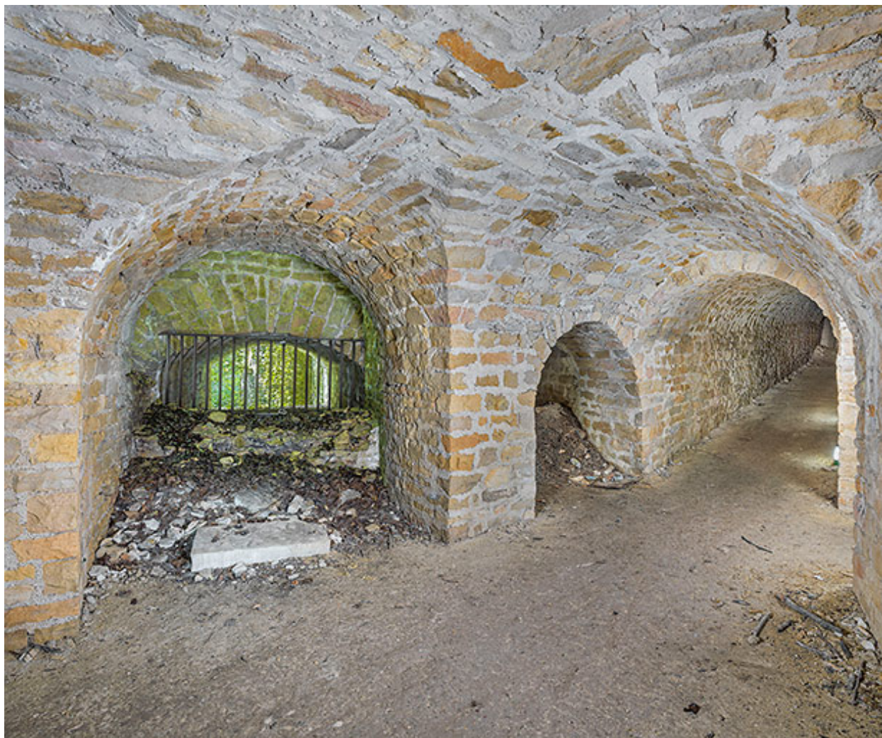
Créneau de tir en direction du fossé.
