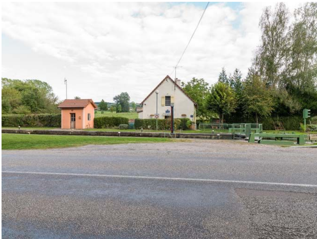
Vue d'ensemble du site d'écluse.
