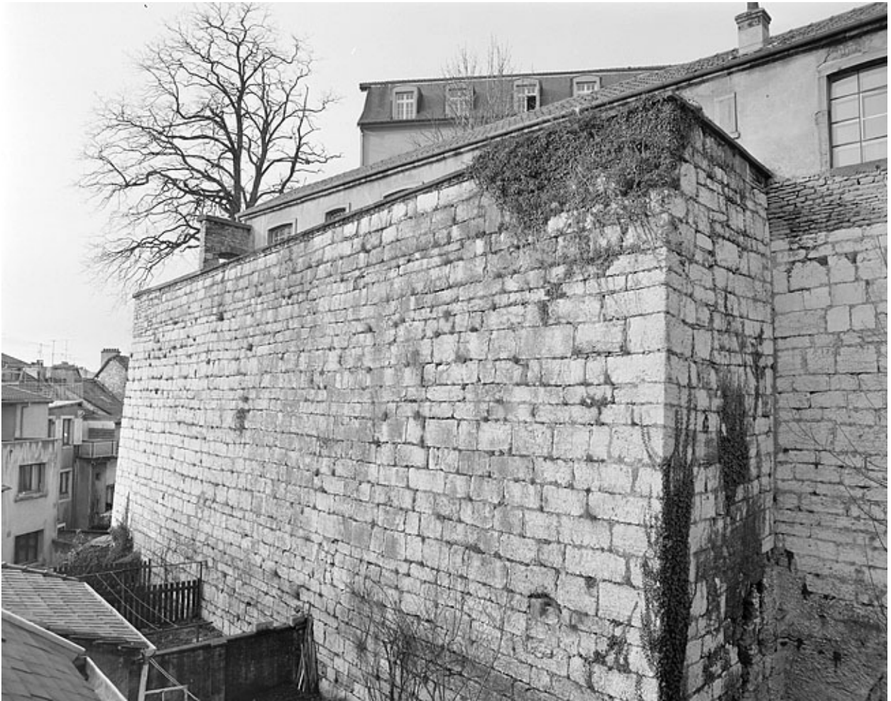
Enceinte. Partie sous le Vieux Château (j).
