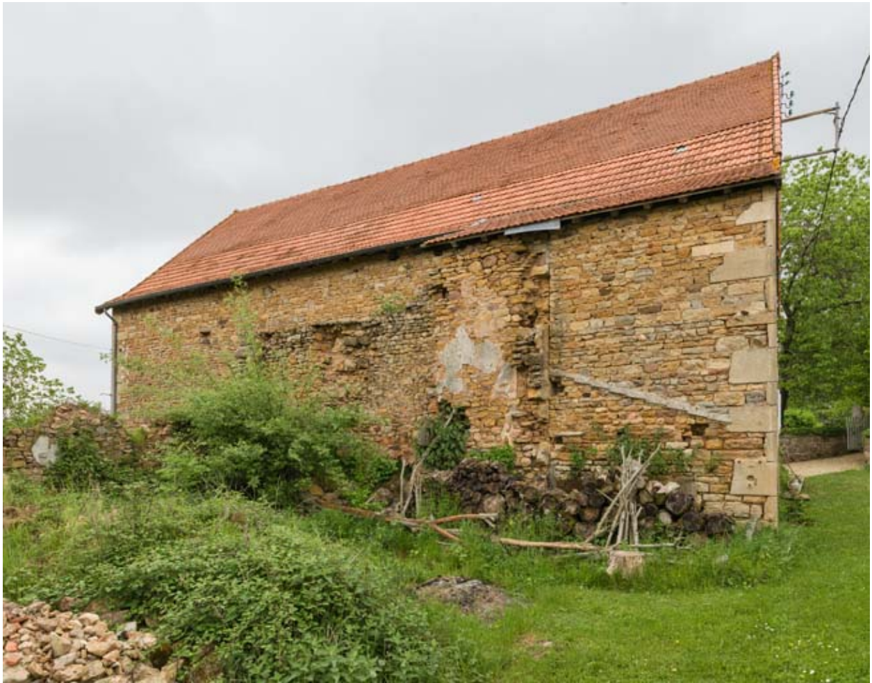
Façade postérieure de l'étable.
