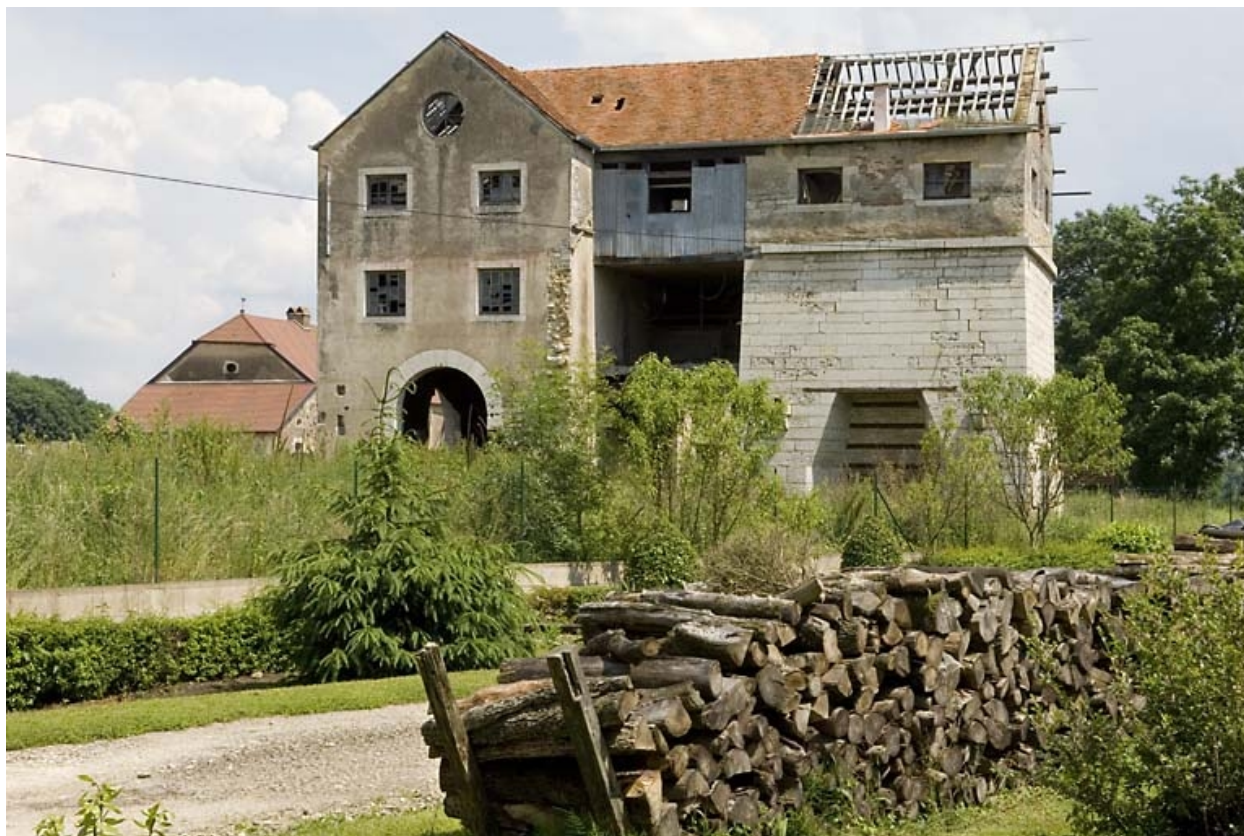
Façade antérieure du haut fourneau.
