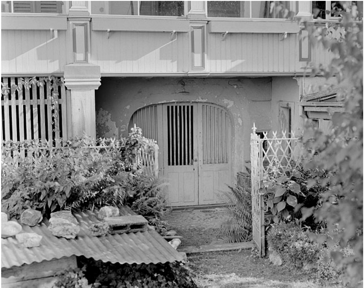
Porte ouvrant sur la deuxième cour, vue du jardin.
