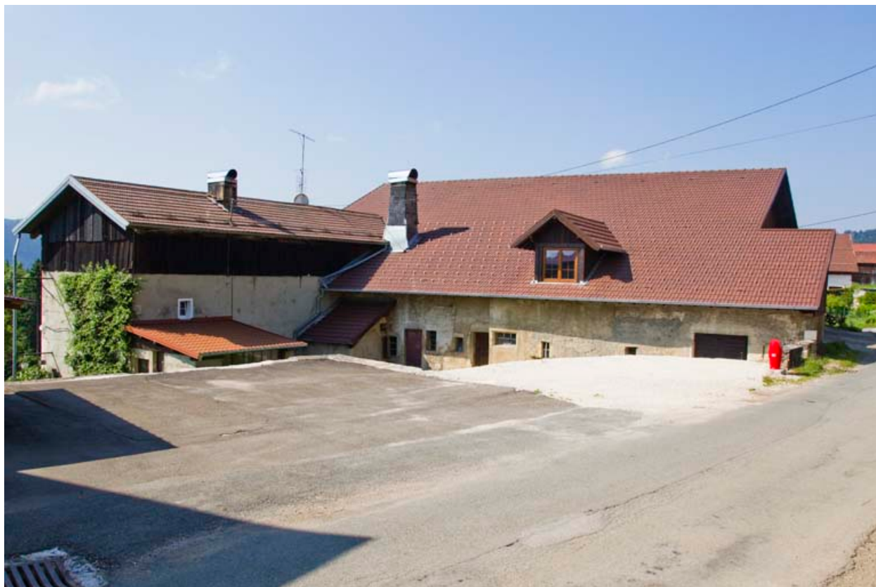
Façades postérieure et latérale gauche.
