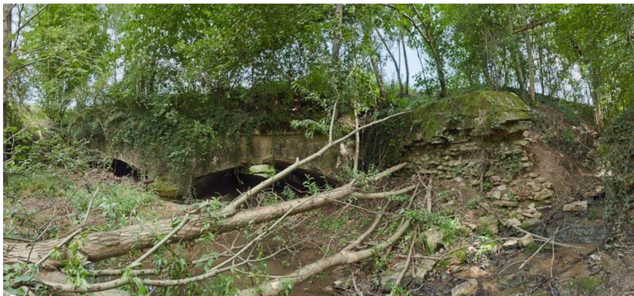
Vue des deux arches de l'aqueduc.
