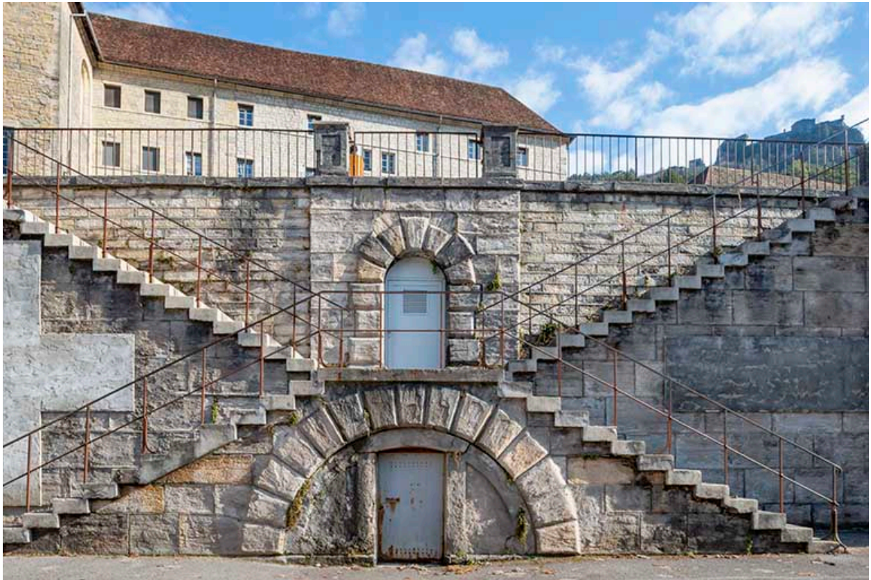
Façade sur la rue Charles Magnin, vue rapprochée de face : rampes de l'escalier.
