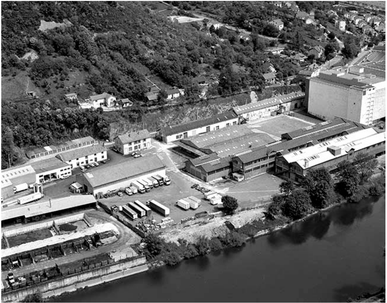
Usine B : bâtiments de l'ancienne papeterie.
