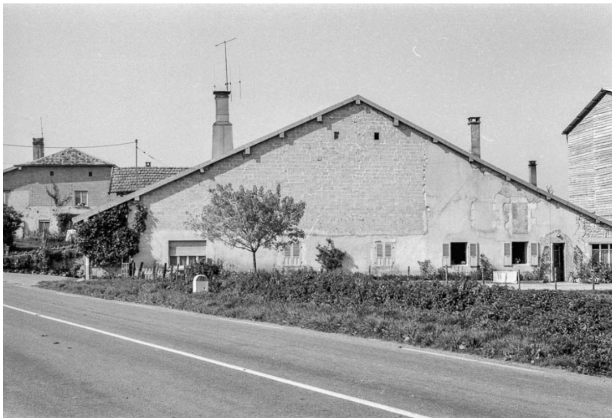
Ferme cadastrée 1961 AB 45 : façade antérieure.
